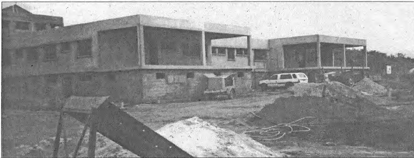
A construção da nova Casa do Gaiato de Moçambique prossegue a bom ritmo
